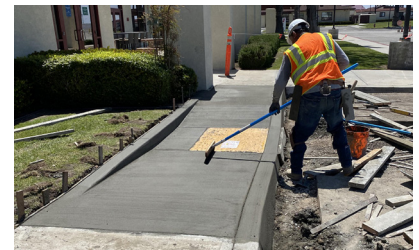
ADA ramp construction
